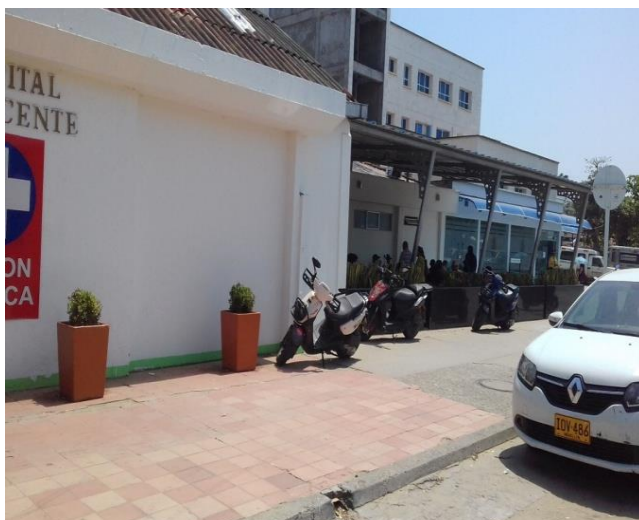
Ilustración 1. Hospital San Vicente de Arauca ESE
