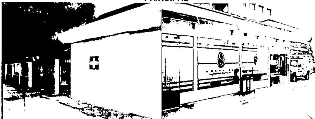
IMAGEN 49. ACCESIBILIDAD AL SERVICIO DE URGENCIAS Y AL EDIFICIO PRINCIPAL
